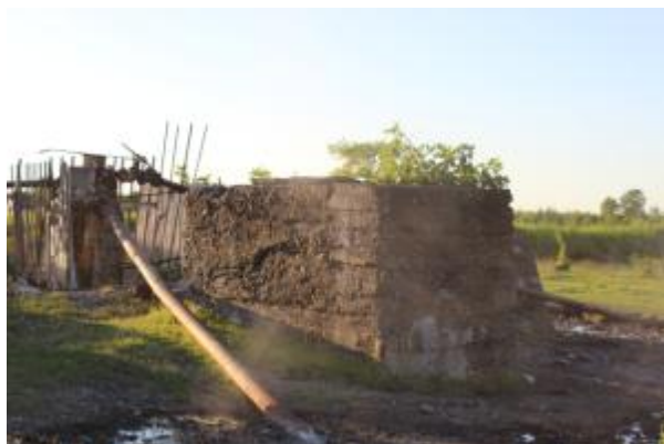
3326 მ სიღრმის თერმული ჭაბურღილი ქვალონ-ახალსოფლის ტერიტორიაზე
