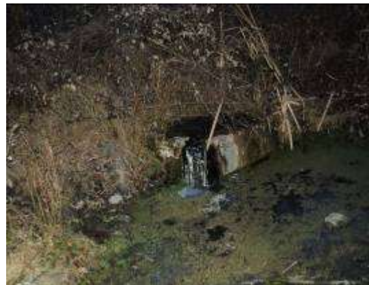
ბეტონის ჭით დაკაპტაჟებული ბუნებრივი გამოსავალი
